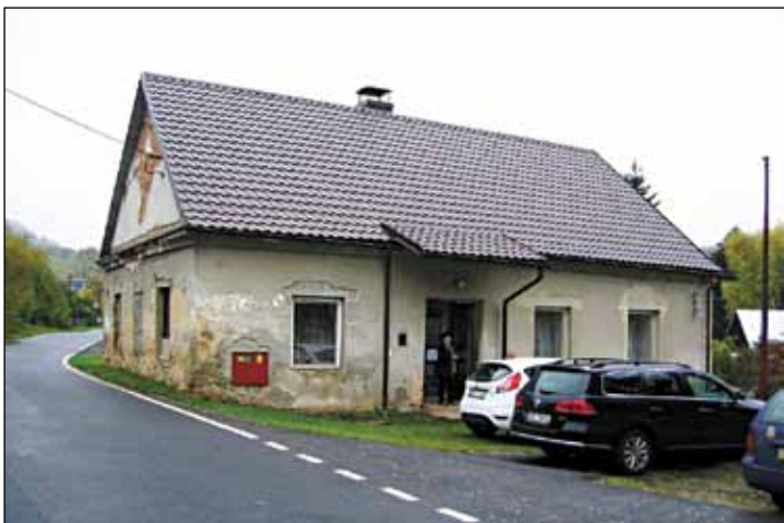
Kulturní dům v Mostkově před zateplením
