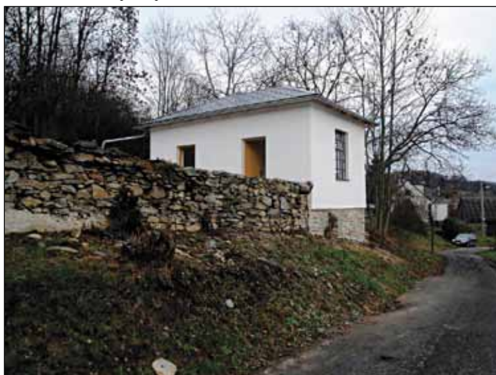
Márnice v Třemešku po opravě
